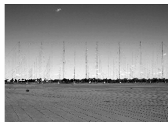
图3 统计型MIMO雷达范例:澳大利亚OTHR发射阵列
