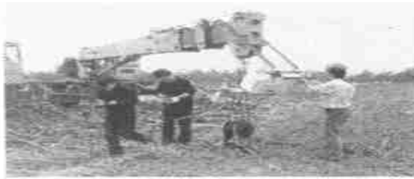
图 1 测量用吊车与散射计安装
